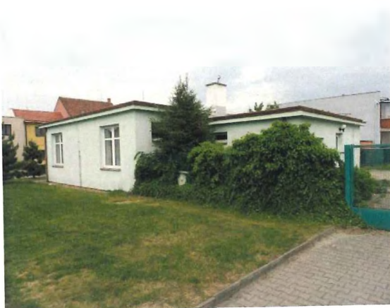
Celkový pohled z ulice Hybešova
