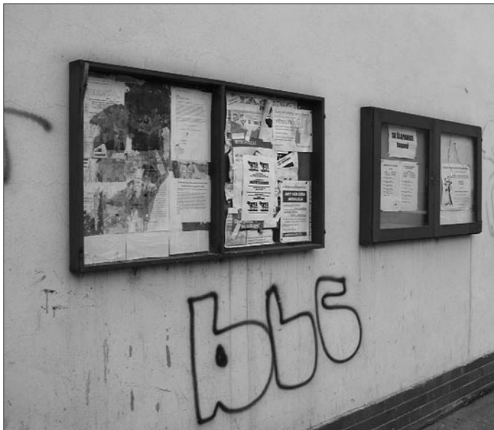
Zničené informační skříňky na ulici Brněnská na OD Lípa
