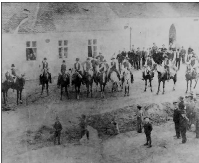
Příkop odvádějící dešťovou vodu na Brněnské ul. kolem roku 1900 archiv Josefa Kopeckého
