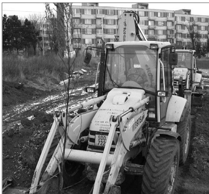
Stavba haly velkoobchodu pro firmu Merida, 28. ledna 2005
