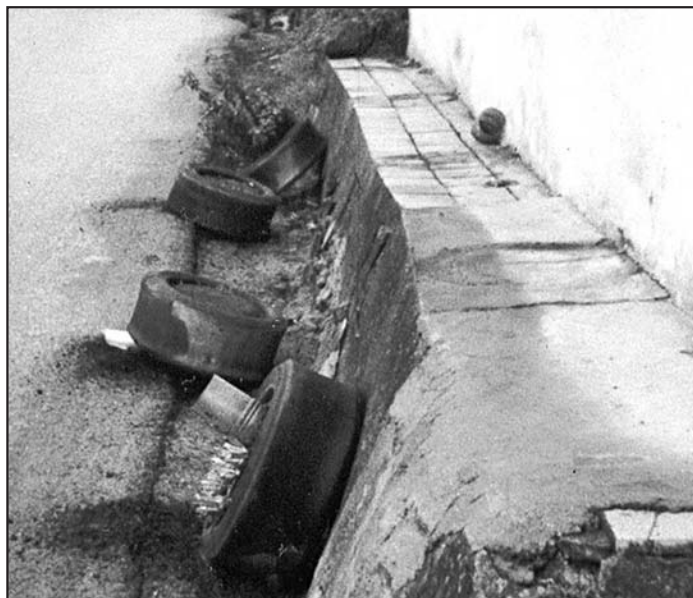
Stále znovu shazované květiny z podezdívky domu na Ponětovské ulici, foceno majitelem nemovitosti
