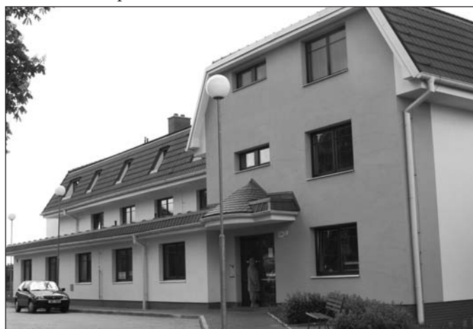
Hlavní vchod do budovy DPS
