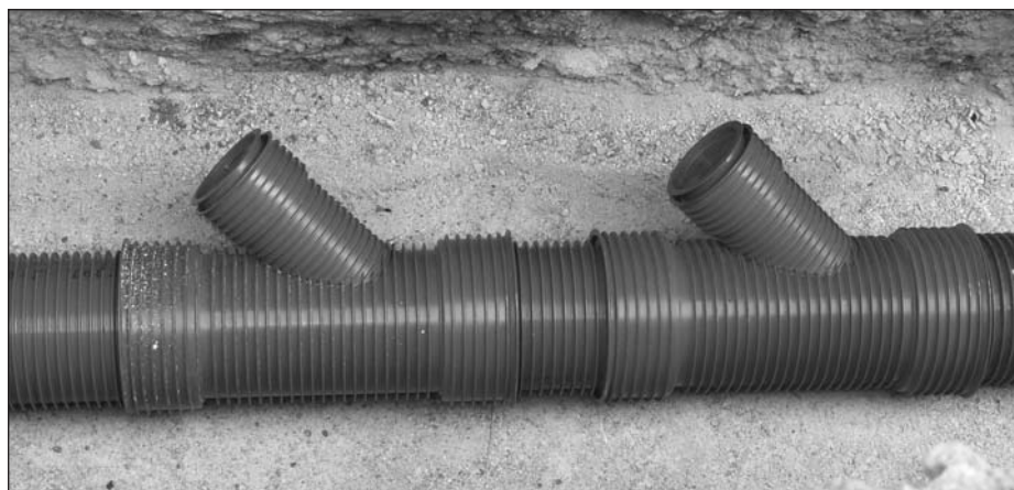
Odbočky z hlavního kanalizačního řadu nachytné ke stavbě přípojek
