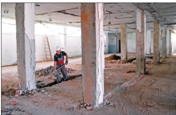
Rekonstrukce Základní školy, 21. 7. 2009, foto M. Černá.
