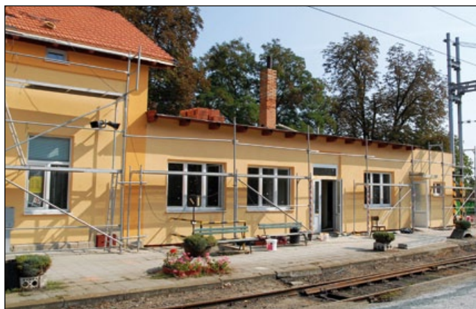
Oprava vlakového nádraží, 23. 9. 2009, foto M. Černá.
