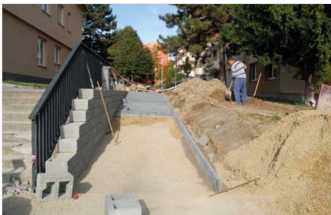
II. etapa revitalizace panelového sídliště, 29. 9. 2011, foto J. Nevřková
