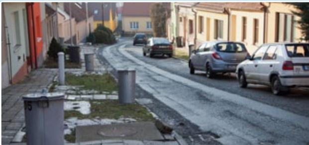
Rekonstrukce místní komunikace na ulici Kosmákově
