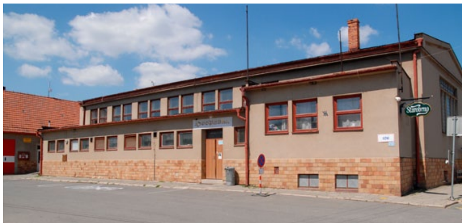
Stávající podoba kulturního domu v Bedřichovicích, foto Jitka Nevřklová
