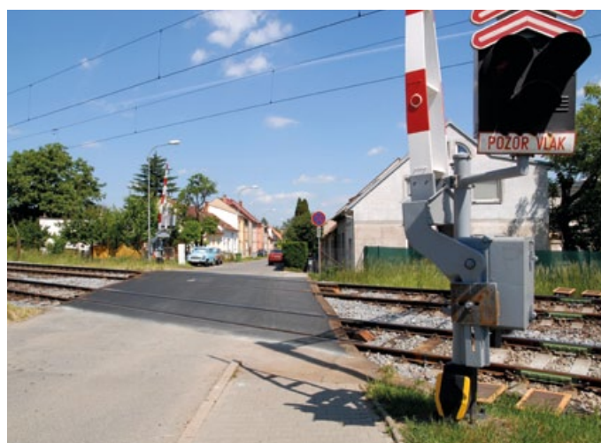
Opravený železniční přejezd na ulici Švehlově, 25. 5. 2011, foto J. Nevřková
