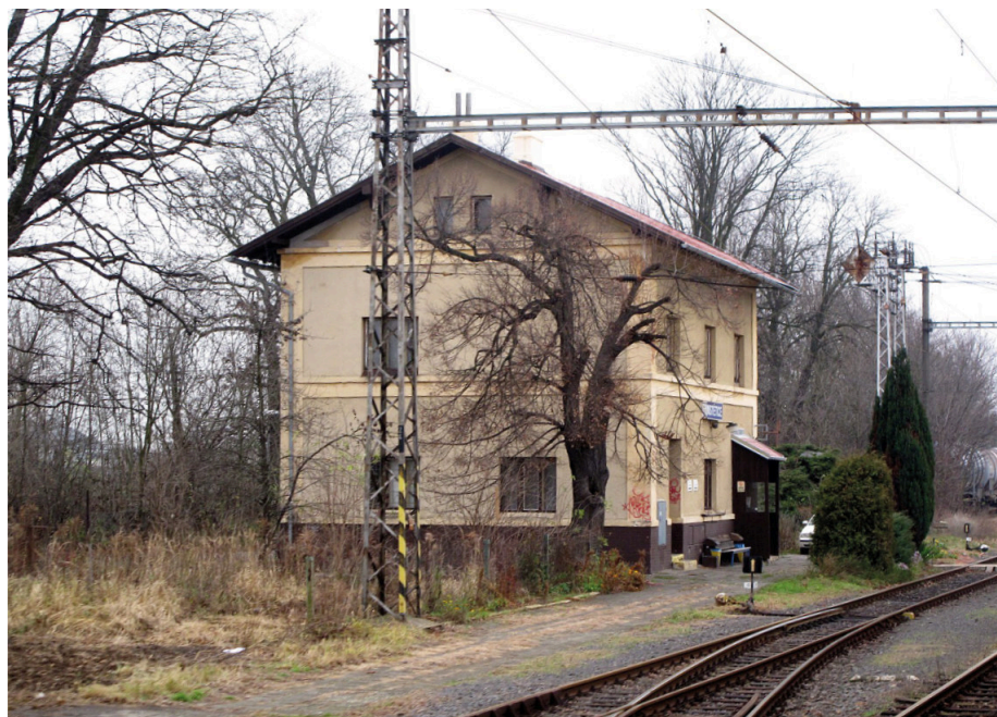
Nádražní budova v Mstěticích – současný stav. Zdroj: wikipedie.cz
