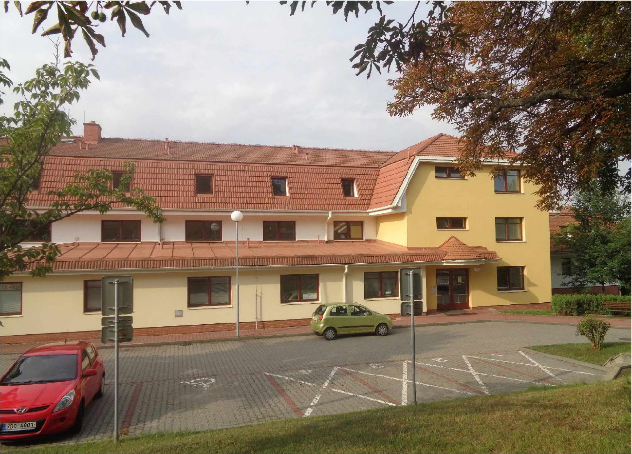
Obrázek č. 2.1.2.1: Pohled na řešenou budovu
