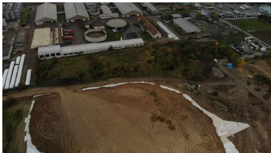
Průběh prací na rekultivaci skládky.
